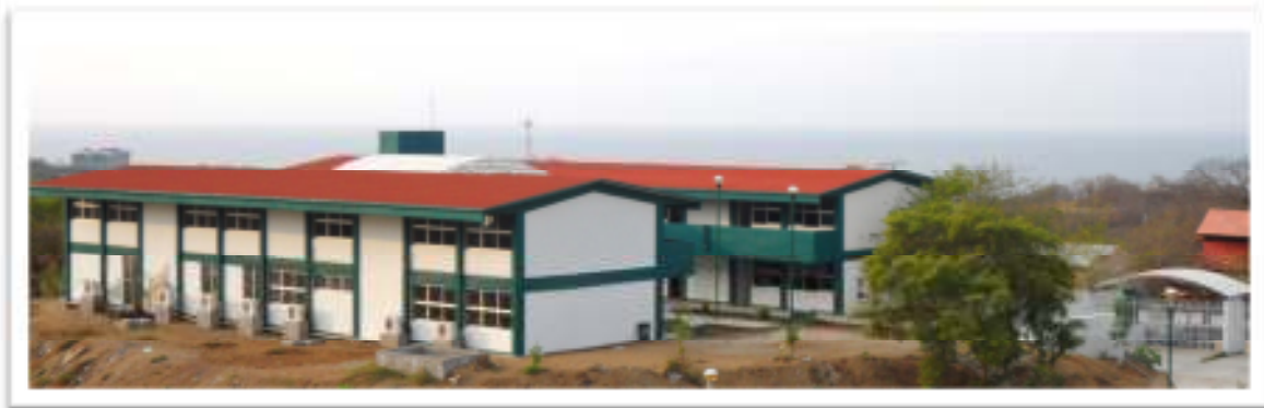
Fotografía 31: Fachada principal de plantel 21 – San Pedro Pochutla
