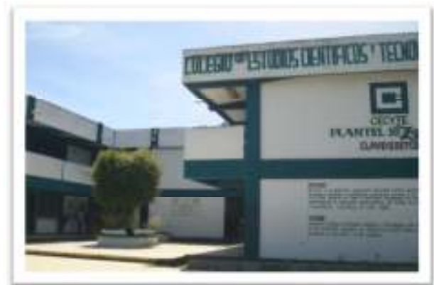
Fotografía 23: Edificio principal del plantel 10
