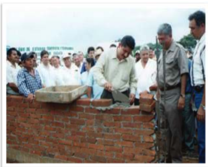
Fotografía 36: Construcción del 2do laboratorio, plantel 30
