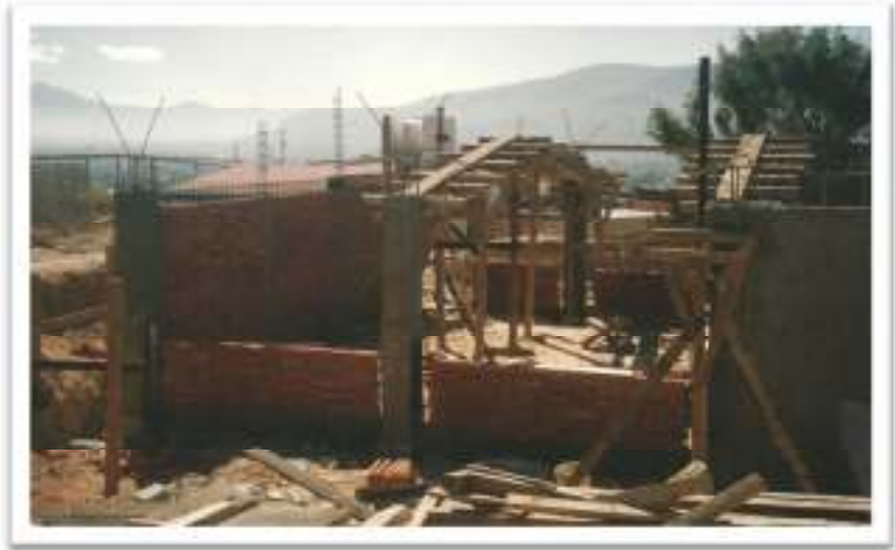
Fotografía 5: Construcción del Cecyte 01, 1993
