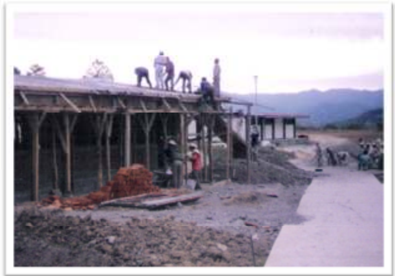
Fotografía 12: Construcción del laboratorio, plantel 03 - 1994
