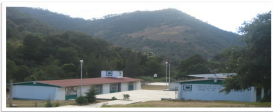
Fotografía 42: Vista del EMSaD 20 – San Miguel Peras
