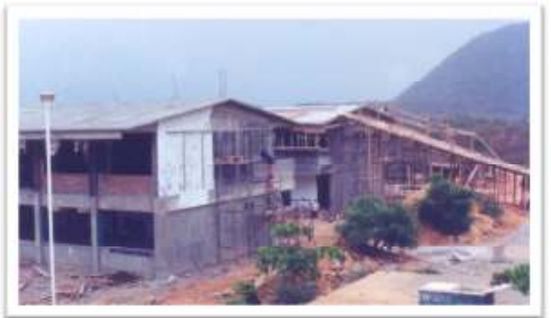
Fotografía 19: Construcción de la 1ra Etapa plantel 06
