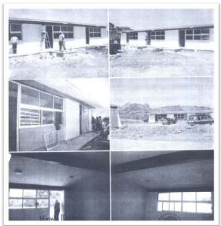
Fotografía 38: Construcción primera etapa de plantel 35
