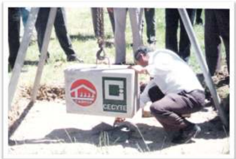
Fotografía 11: Colocación de la primera piedra, plantel 03 - 1994
